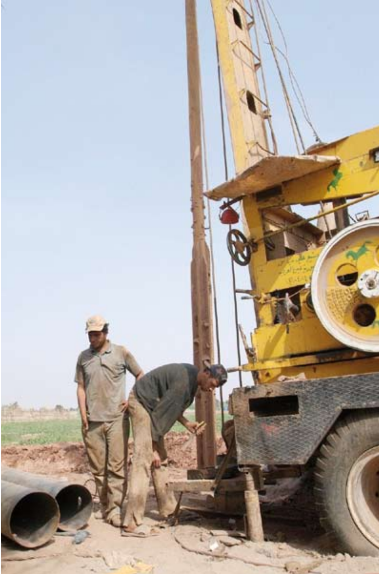
حفر آبار المياه الجوفية
